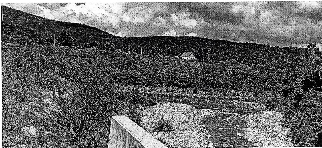
Slika 3: Lokacija rijeke Tare gdje budući nadvožnjak presijeca korito rijeke
