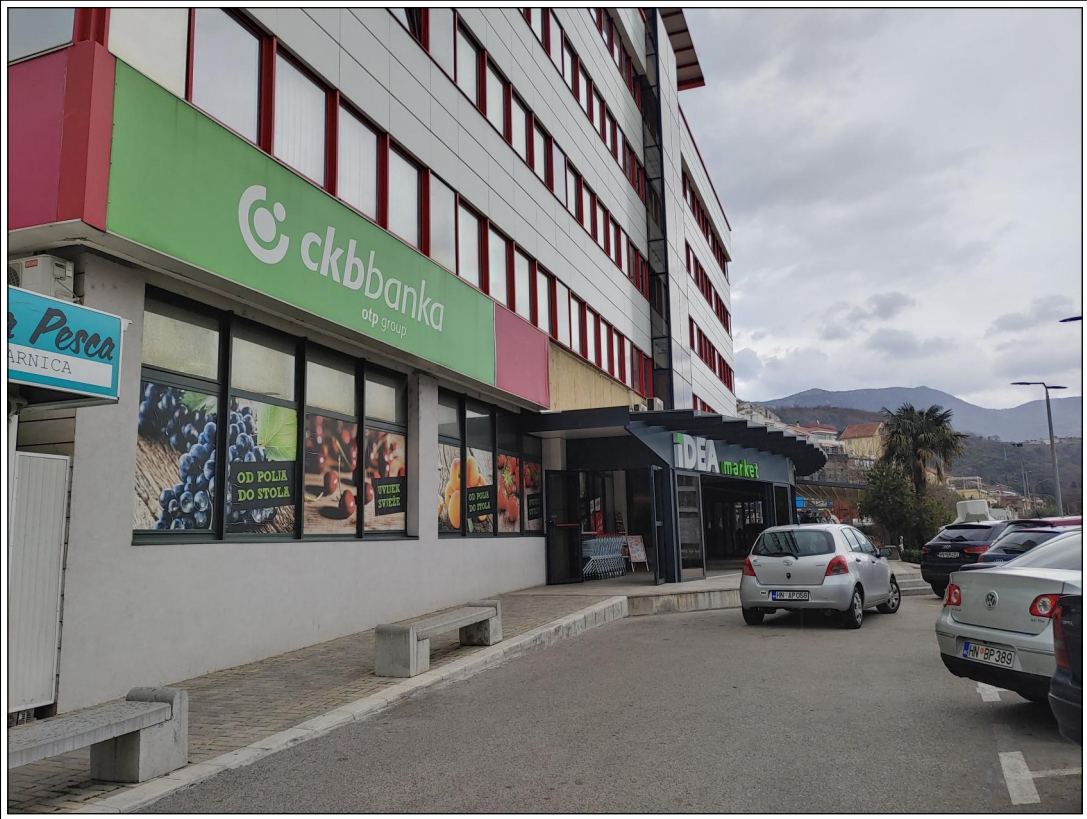
Fotografija 4 - ulazna fasada postojećeg objekta i izgled nadstrešnice koji je ponovljen u bočnoj dogradnji
