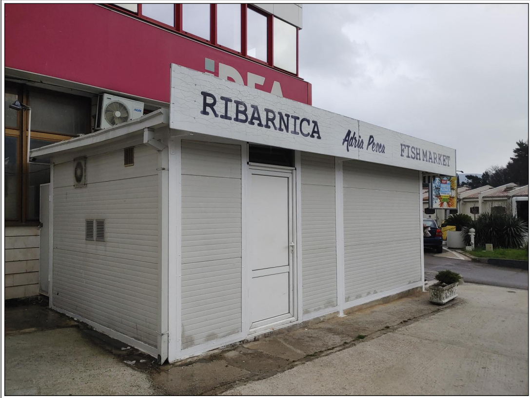
Fotografija 1 - izgled postojeće ribarnice
